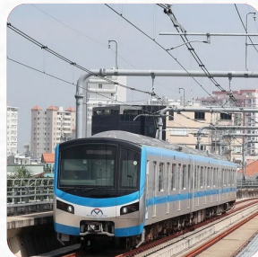
Dự án Metro Bến Thành - Suối Tiên
