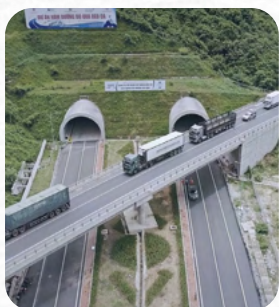
Dự án Hầm Đèo Cả
