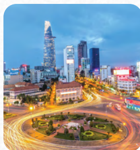
Dự án Các dự án ngầm hóa lưới điện tại TP. HCM
